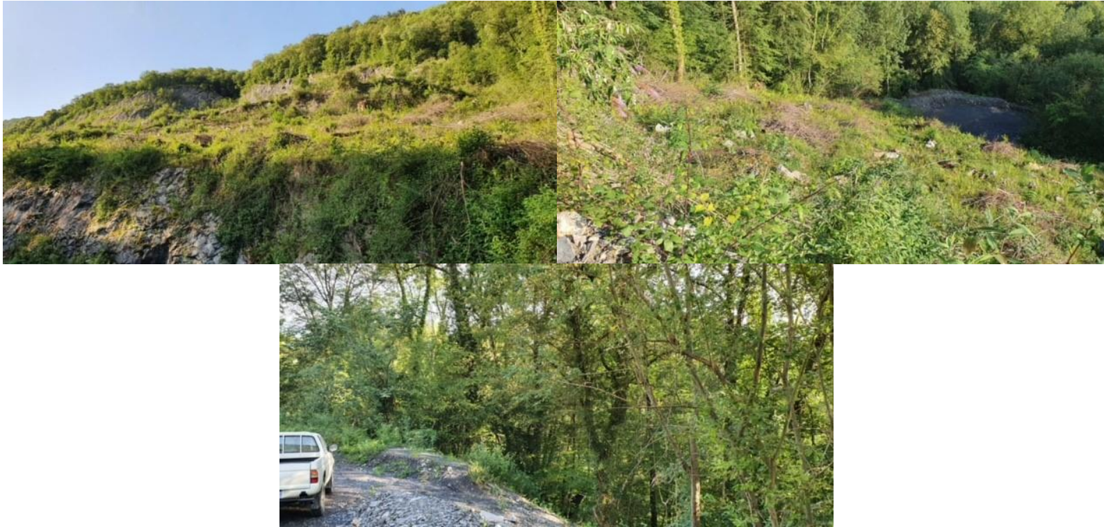
Figure 20 : photographies des zones déboisées et des zones boisées faisant l'objet d'un évitement : à gauche et à droite, zone déboisée et à droite, zone évitée
